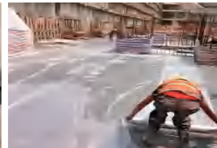
> 混凝土覆盖薄膜养护
