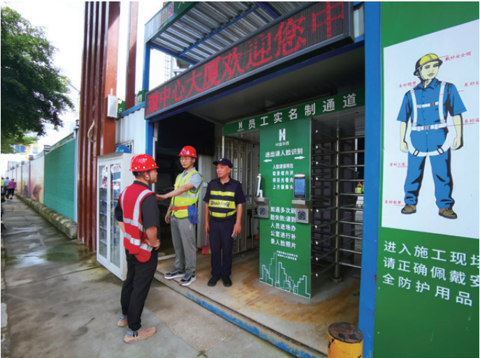
施工现场出入口把控
