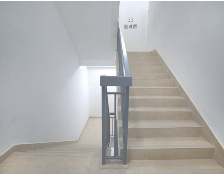
室内楼梯铺贴整齐，高度合理
