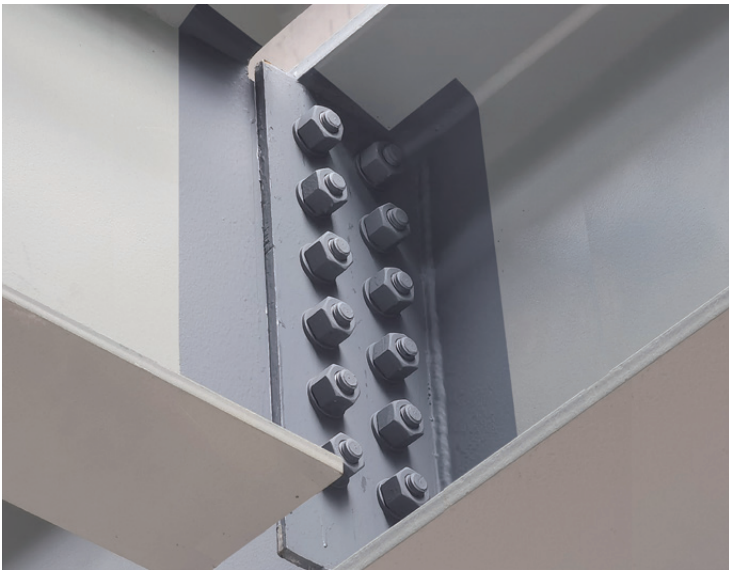
钢结构安装精确，防锈漆喷涂均匀，螺栓排列整齐
