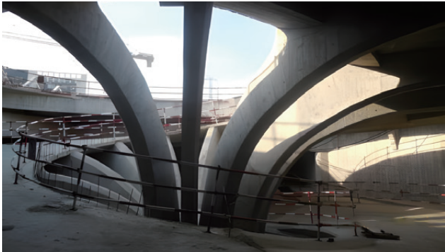
变径螺旋混凝土汽车坡道
