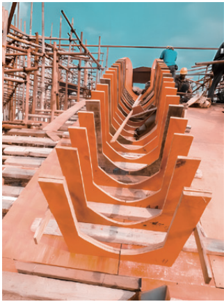
卡槽模板制作安装
