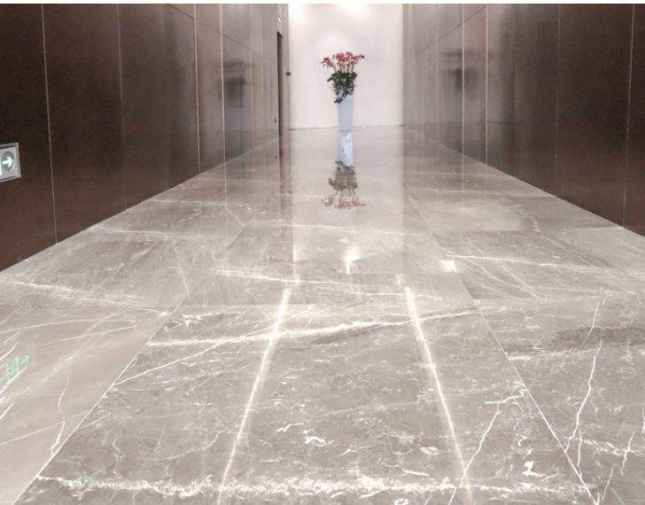
地面铺贴平整，对缝整齐
