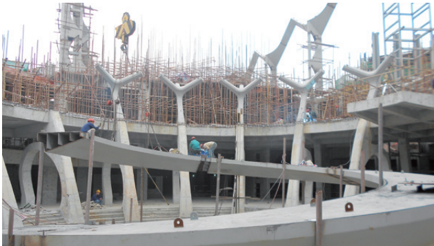
变径螺旋钢结构人行坡道
