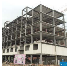
钢框架结构 钢框架支撑（剪力墙）结构
