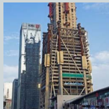
钢框架-混凝土核心筒结构
