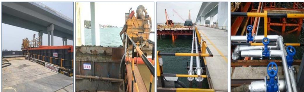
图2 水上泥浆循环回收系统现场图片
