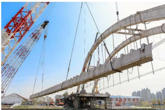
图2 两台浮吊将系杆吊离
