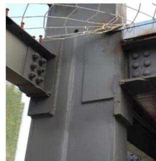
图4 隐藏式梁柱节点现场图
