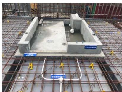
图 2 PC 卫生间沉箱安装样板
