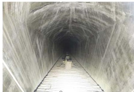
图4 猴子岩出线洞衬砌完成效果图
