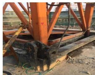
图 8 塔吊与预埋节连接
