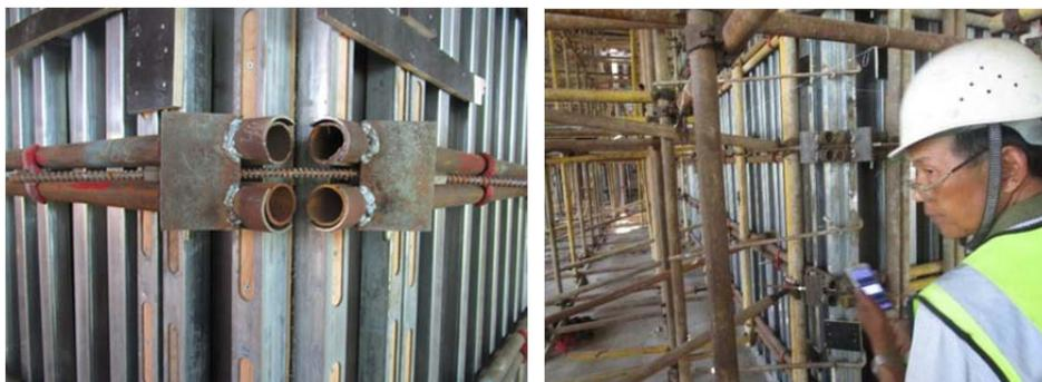
散装木模板体系即使用 50mm 钢包木+方钢管、18mm 厚清水模板利用专利“水平禅缝操
