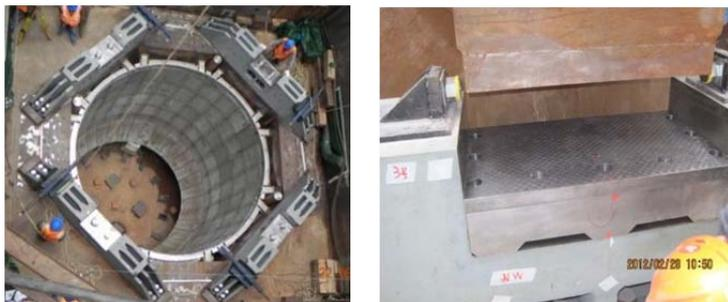
图1：反应堆压力容器的保温和就位调整工装
