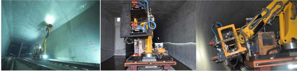
图3 不同类型断面打孔作业
