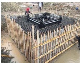
图 6 塔吊基础承台施工
