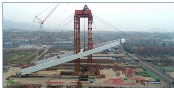
(2)设计研发了拱形钢索塔内侧设置 4 组提升塔架，降低提升装置的高度，通过合理设置提升吊点及分级同步置换液压钢绞线缆风绳，将竖
