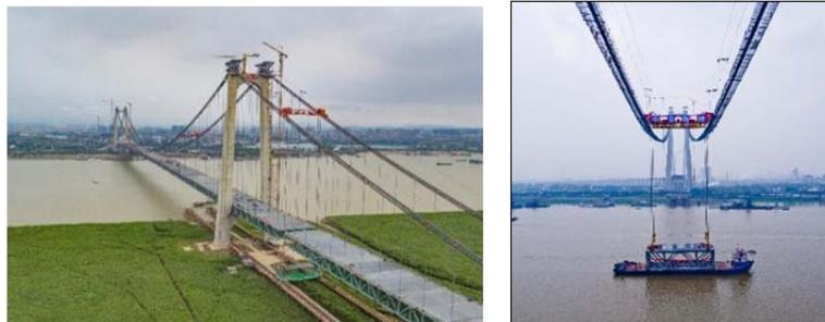
图4 杭瑞高速洞庭湖大桥缆载吊机应用情况
