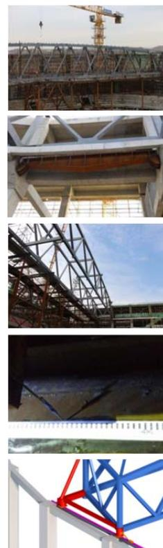
2.3 单榀桁架拼装起拱控制及卸载技术；针对滑移安装高空拼装大跨度多榀桁架由于分段点多，易反复进行施工，造成大量人工浪费拼装过程起拱及卸载在施工过程中操作不当存在安全隐患，同时质量得不到有效保证
