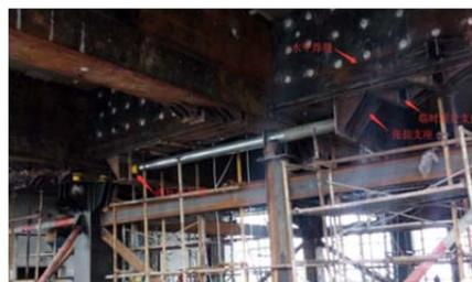
图 4.4 梁底钢板张拉锚固现场照片
