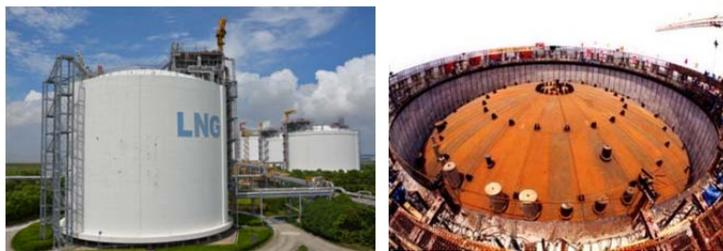
图1 五号沟 10 万 m<sup>3</sup>LNG 储罐
