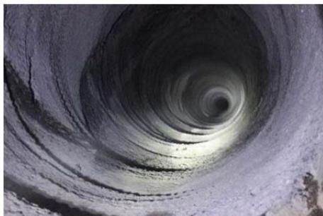
图3 斜井导孔贯通效果图
