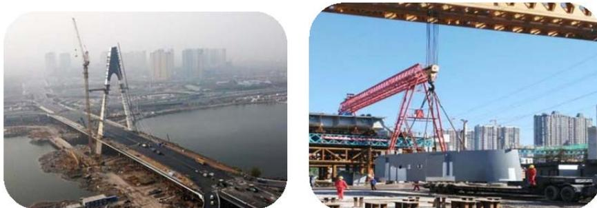
图1 陆地化施工及大节段组拼安装
