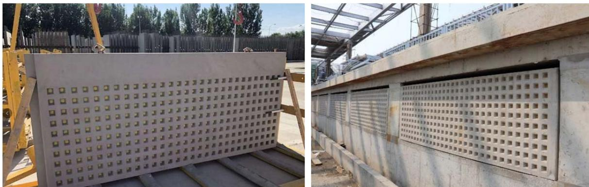
图1 装配式吸声降噪站台墙现场应用实例
