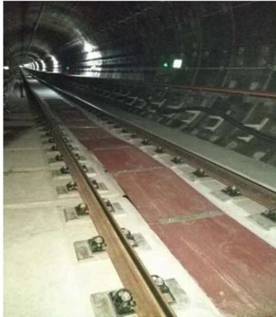
图7 内置式泵房现浇轨道结构
