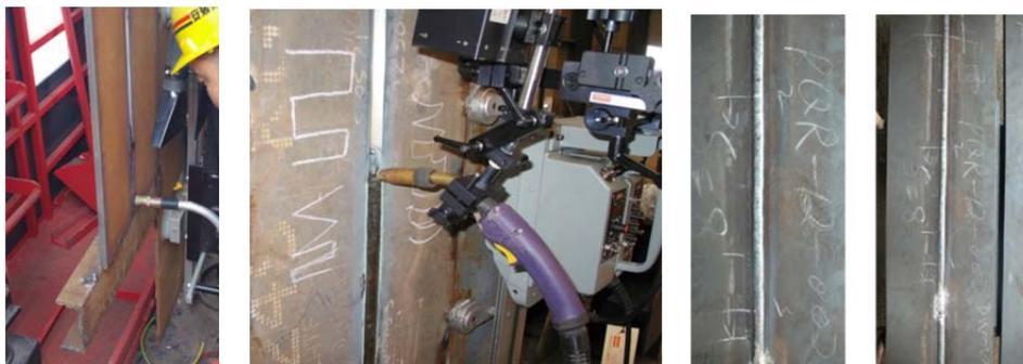
图3 大型储罐立焊缝焊接
