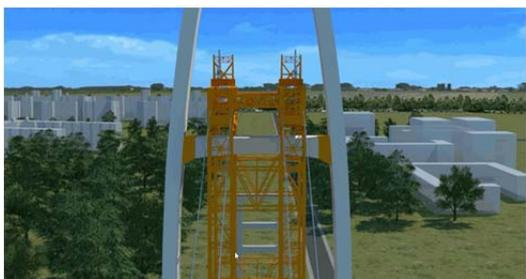
自主研发并形成了拱形钢索塔内侧提滑组合的竖转安装成套技术，采用“卧式拼装，边提边转”的方式施工，解决了本项目拱形钢索塔安装难题。
