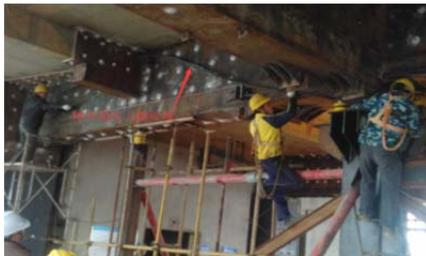
图 4.3 体外预应力钢绞线安装现场照片
