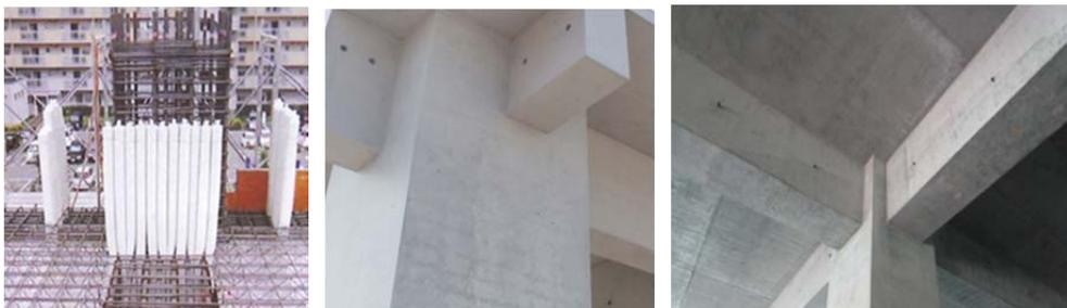
采用“充气式隔板技术”有效解决了梁柱接头密封不严、浇筑不均匀的问题。
