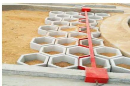
图 5 空心六棱砖铺设快速精确定位装置
