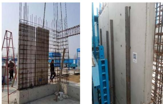
图 L 型角铁      图 1 预埋内丝与螺杆、背楞调整位置
