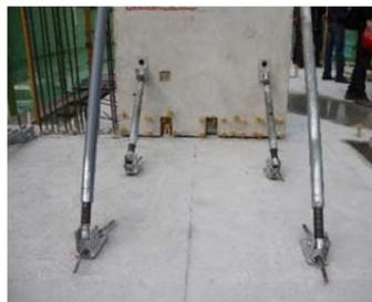
图 4.5 斜支撑固定
