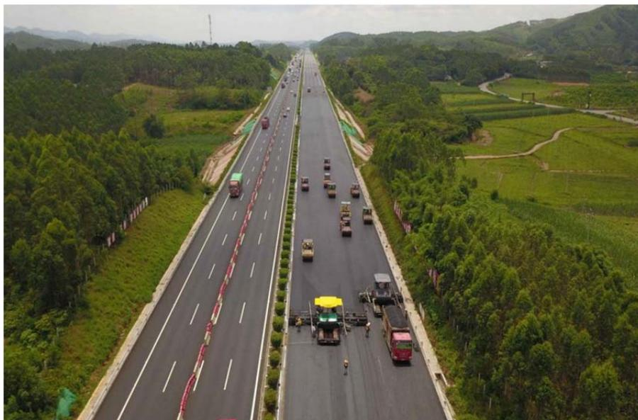
目前国内外采用振动搅拌技术主要用在中刚性基层用以搅拌水泥稳定碎石类材料，在沥青面层结构上的应用并不多见。该技术在现在广西柳南高速上得到了推广应用，填补了振动搅拌技术在沥青面层上应用的空白，为广西高等级路面建设提供了更优更好的选择。
