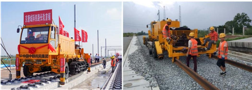
研究成果成功应用于杭黄、成贵和蒙华等铁路项目，共计完成 1640km 铺轨任务，实现了在 20%的线路坡度上铺轨作业，有砟轨道日铺轨 2.5km，无砟轨道平均日铺轨 8km，施工效率高，创造了铁路铺设的新模式，书写了铁路建设领域施工装备的新篇章。
