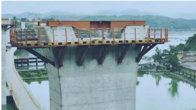
图 2 大跨径大曲率高墩槽型梁无支架顶推施工工艺中的承载梁
