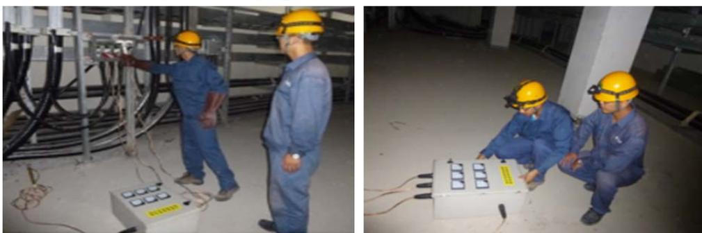
图 3 接地箱带电接线检修
