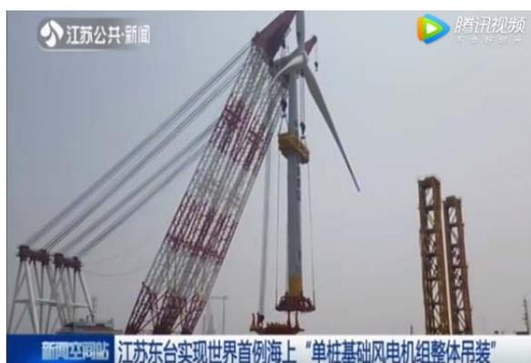
课题依托国华东台四期（H2）300MW 海上风电场项目工程，该风场离岸直线距离 42km，为目前国内离岸距离最远的海上风电场。工程所处海域受季风、波浪、涌浪、水深等自然条件影响大，采用单桩基础的风机整体安装技术，国内外没有应用先例，无先例可学习、无经验可借鉴、无规范可参考，风机总体重量近 500t，重心高度达到 42m，高耸和大迎风面的海上安装，作业难度极大，同时风机部件对安装的精度和加速度要求高，项目复杂程度较高。
