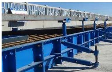
图2 “F”形侧向模板及振捣装置走行轨道
