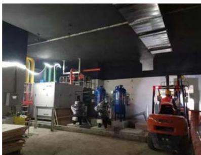
图7 装配式智能化泵组模块安装
