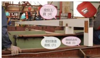
图8 密封滑道安装
