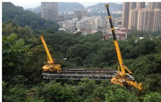
自行式桥面吊机吊装施工技术，与塔吊、汽车吊、缆索吊等技术相比，未发生施工便道开挖、基础拆除爆破费及垃圾处理、绿化恢复费等费用，并且可以多区域同时施工，缩短工期，技术经济效益显著。
