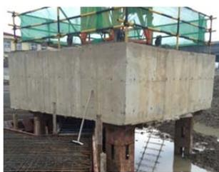
图 7 塔吊基础施工完成
