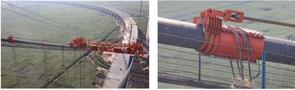
图2 缆载吊机行走锚固装置
