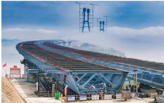
图 1 大跨径大曲率高墩槽型梁无支架顶推施工工艺运用于沙埕湾跨海大桥工程
