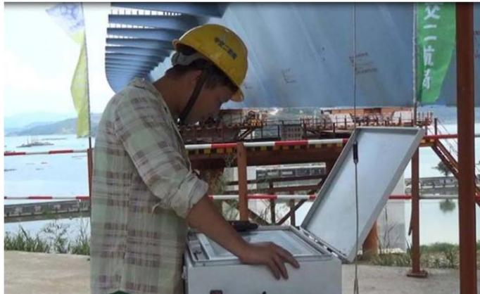
图 3 大跨径大曲率高墩槽型梁无支架顶推施工工艺中的中央控制系统
