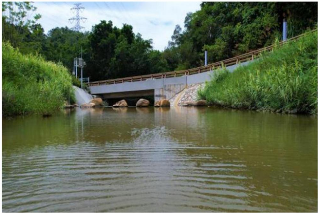
拆除重建危桥
