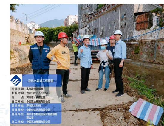
区水务局分管领导现场检查
